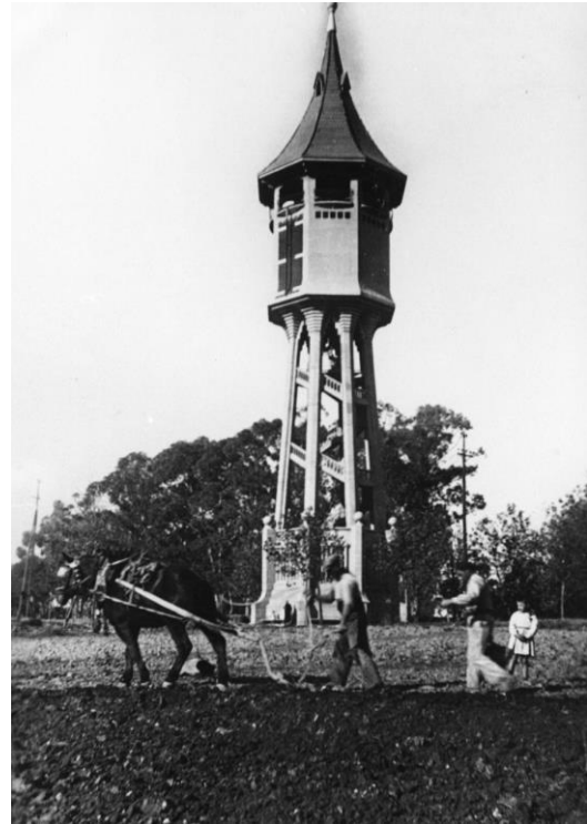
TORRE DE L'AIGUA. SABADELL. Fotografia de l'Arxiu Fotogràfic de la UES publicada al calendari de l'any 2018, any en què s'ha celebrat el centenari de la construcció.
